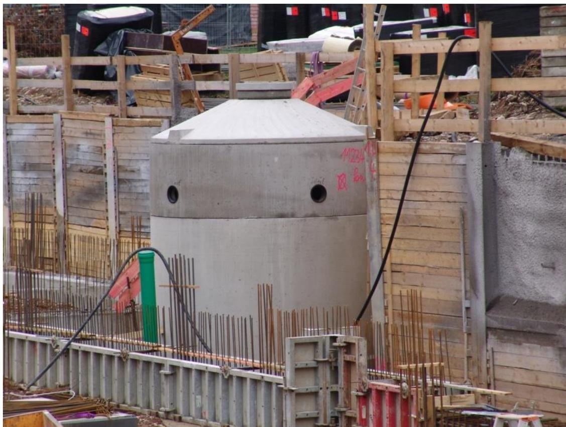
Bei Neubauten müssen seit der damaligen Neufassung der Landeswassergesetze in den 90er Jahren Schwammstadtprinzipien von Gesetzes wegen umgesetzt werden: Niederschlagswasser muss dezentral versickert und/oder (zwischen-)gespeichert werden. Hier ein Foto aus dem Jahr 2023 vom Einbau eines großen Regenwasserspeichers bei einem Neubau in der Colmarerstraße.
